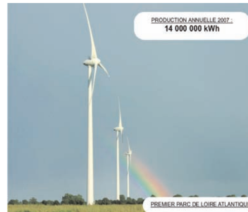
Parc éolien de Soudan (44)
